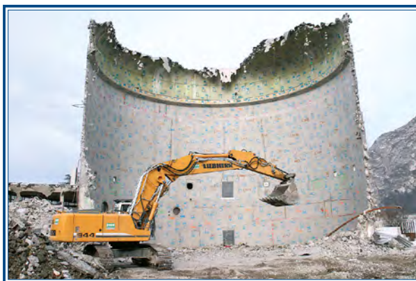
Рис. 3.27. Работы по сносу здания исследовательского реактора Siloé
