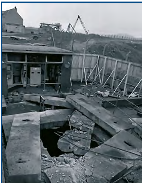
Рис. 2.13. Шахта-хранилище РАО (после взрыва)
