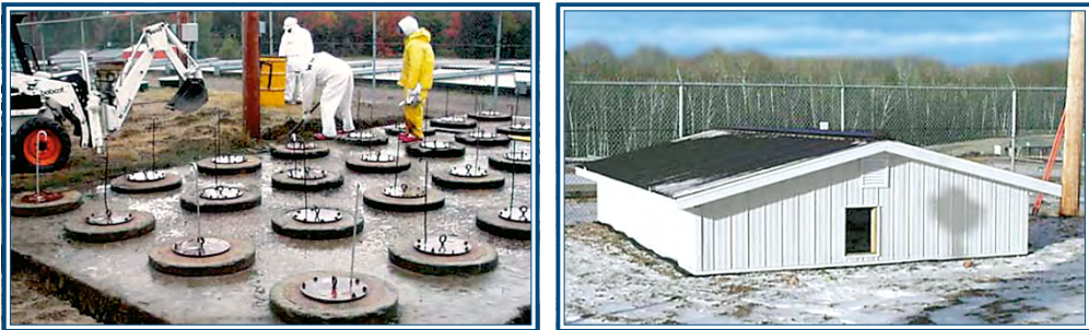
Рис.4.7. Проведение работ по модернизации дренажной системы и сезонные укрытия от атмосферных осадков площадки хранения ОЯТ
