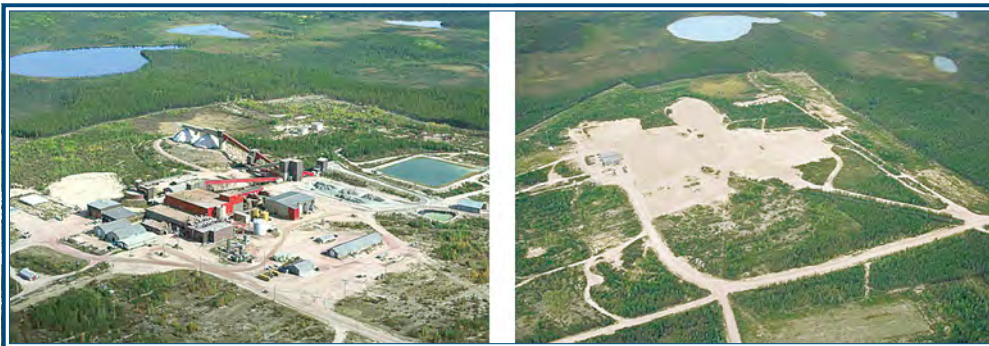
Рис. 4.22. Вид сверху на установки Клафф Лейк в период работы месторождения (слева), вид сверху на площадку после выполнения мероприятий по выводу из эксплуатации до посадки деревьев (справа)
